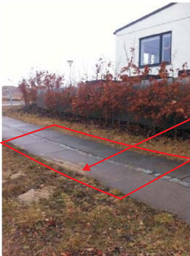
Afretningsand skyllet op mellem fliser
