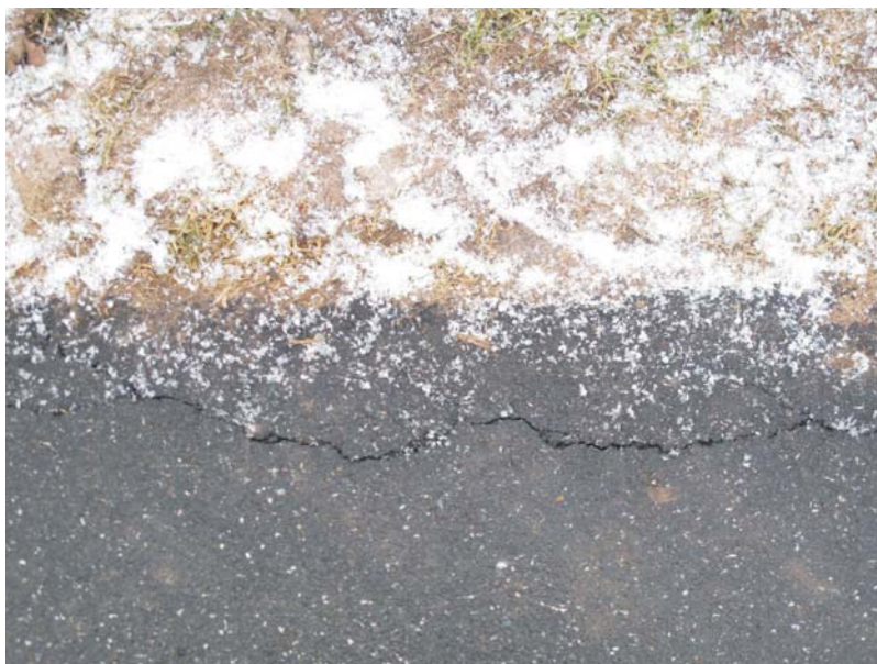
Eks. på udpræget vækst af græs, der kommer op gennem asfalkanten
