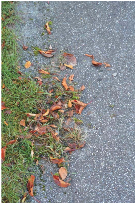
Eks. på udpræget vækst af græs, der kommer op gennem asfalkanten
