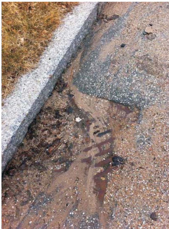
Fuldstændig tilstoppet vejbrønd på stamvejen (11/4-2013)
